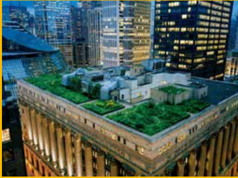
Proyecto: Chicago City Hall Green Roof - Chicago, Illinois Año: 2002 - Impermeabilización: Sistema Sika Green Roof Area: 10500m 2 . - Arquitecto: Thomas W. Vulkovich.
