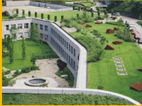
Cubierta ajardinada edificio del Banco Europeo de Inversiones en Luxemburgo.- Sistema Sika Green Roof. Proyecto aprobado por la Asociación Profesional de Green Roof de Alemania (FBB) como el "Techo Verde del Año 2005".
