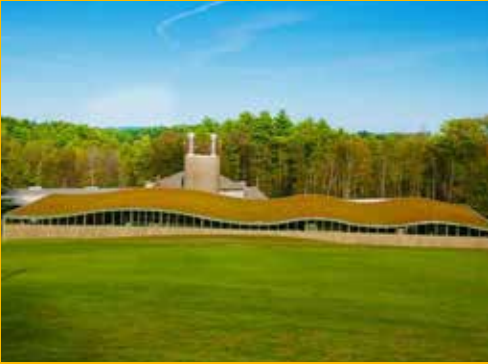
Cubierta ajardinada Planta de Tratamiento de Biomasa Hotchkiss School. (Lakeville, CT, EE.UU.) Sistema Sika Green Roof Area: 1070m 2 - Pendiente: 17%
